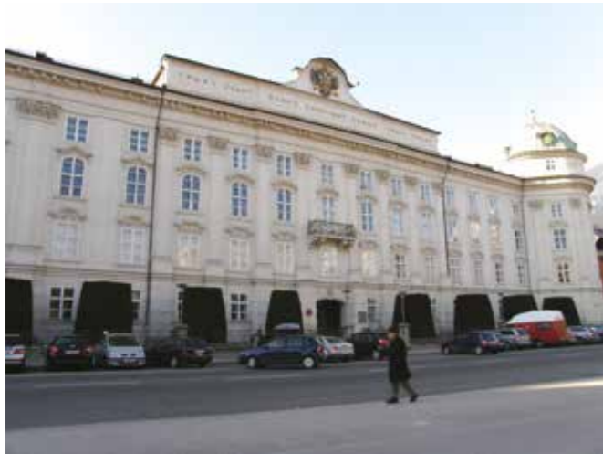
Čudovita palača nedaleč od parkirišča, kjer boste pustili avtodom.
