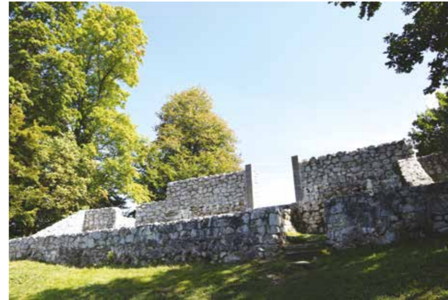
Obnovljeni temelji cerkve
