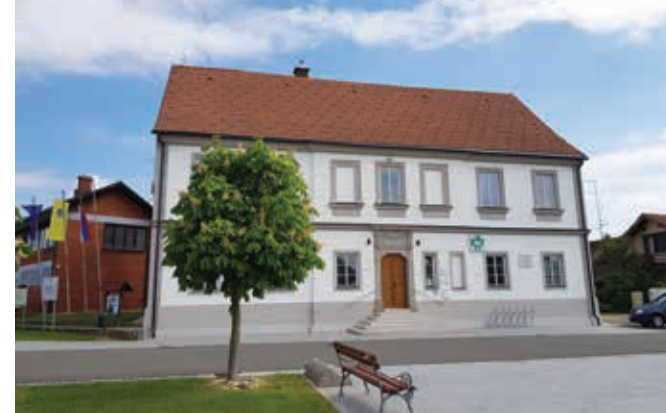
Osrednji trg v Središču ob Dravi je bil nedavno obnovljen.
