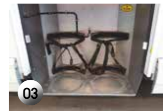
03 Pred vgradnjo je mojster Thomas iz Trume odstranil vse nepotrebne dele plinskega omrežja.
