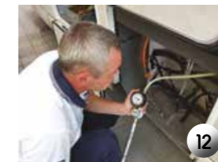
12 Mojster Thomas plinotesnost preveri z napravo – sistem mora 5 minut držati pritisk 150 mb.
