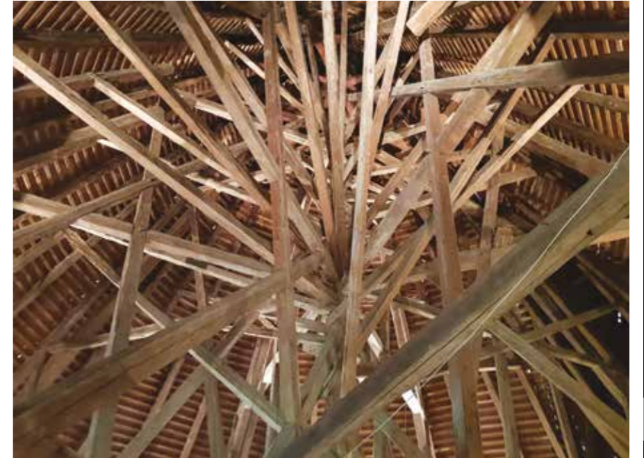
Čudovito ostrešje stolpa je prava paša za oči.
