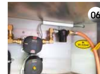
06 Tokrat so vgradili še sistem proti zmrzovanju eisex, ki za delovanje potrebuje napetost 12 voltov.
