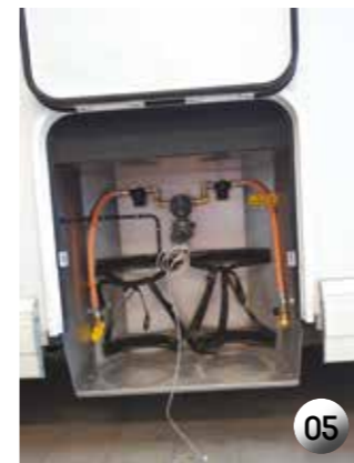
05 Vgradnja komponent sistema je relativno preprosta, še največja težava so omejitve s prostorom.
