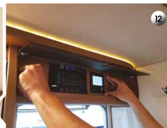
Klimatsko napravo priključijo še na kontrolko CP Plus.
