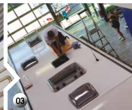
Za potrebe vgradnje strešne klimatske naprave je potrebno odstraniti strešno okno, kjer so že pripravljeni kabli za priključitev.
