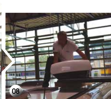
Klimatsko napravo »položijo« na okvir, s čimer je zunanji del montaže končan.
